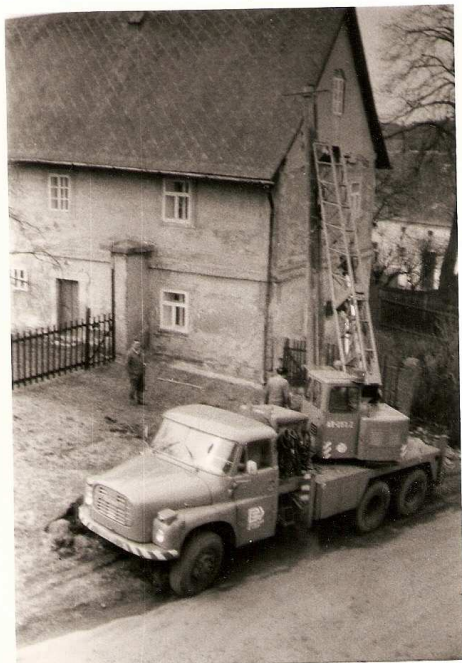
Rekonstrukce elektrického vedení v Krásném Údolí 1989
